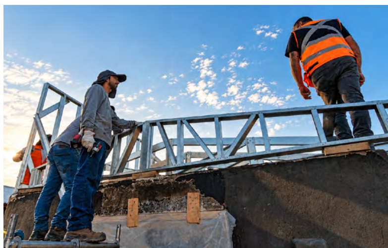
► Manos a la obra: el equipo Sifup comienza con la misión de construir las dos viviendas de los jugadores afectados.
